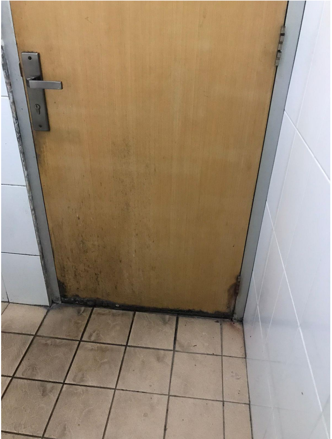
PINTU KEROOPOS RUANG FLAMBOYAN 1
